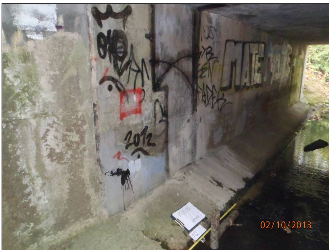
Obr. č. 3 - opěra Valašské Meziříčí, povrch opěry je bez poruch
