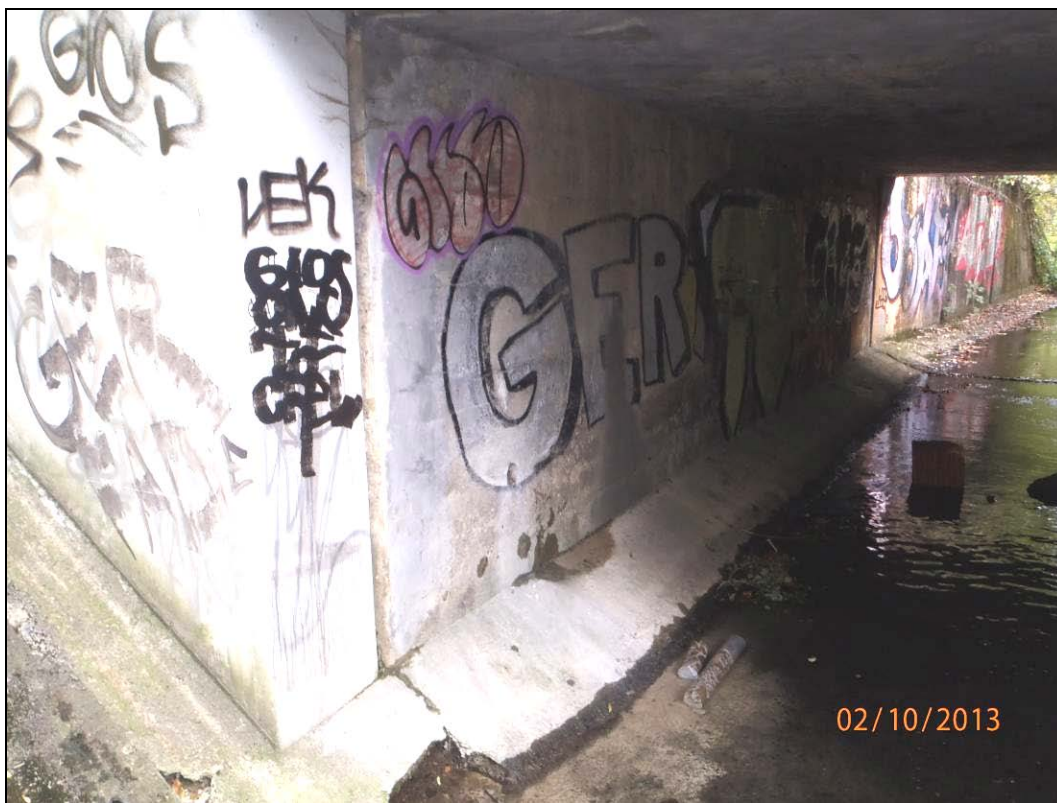
Obr. č. 4 - opěra Hustopeče, povrch opěry je bez poruch
